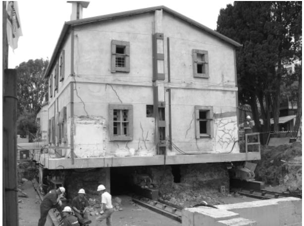
Unter Denkmalschutz gestelltes Templerhaus von Sarona beim Verschieben an den neuen Standort Foto: N.Szmuk
